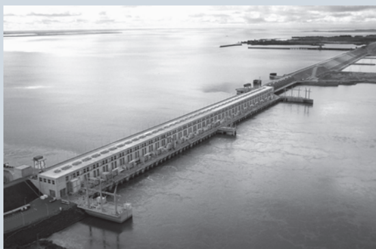
Complejo hidroeléctrico Yacyretá-Apipé
